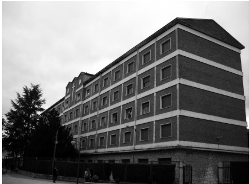
El edificio de "Las Francesas" acogió durante casi dos cursos al IB Vela Zanetti.
